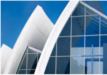
建物の正面に低鉄フロート板ガラスのPilkington Optiwhite™を採用することで、従来のフロート板ガラスよりも高い光透過性が得られます。
