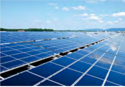
薄膜太陽光発電モジュールは、低コストで発電が可能ですが、広い設置面積を必要とします。
